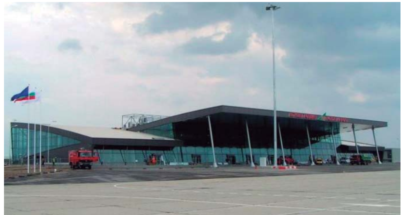
La terminal de Plovdiv vista desde el lado aire.
